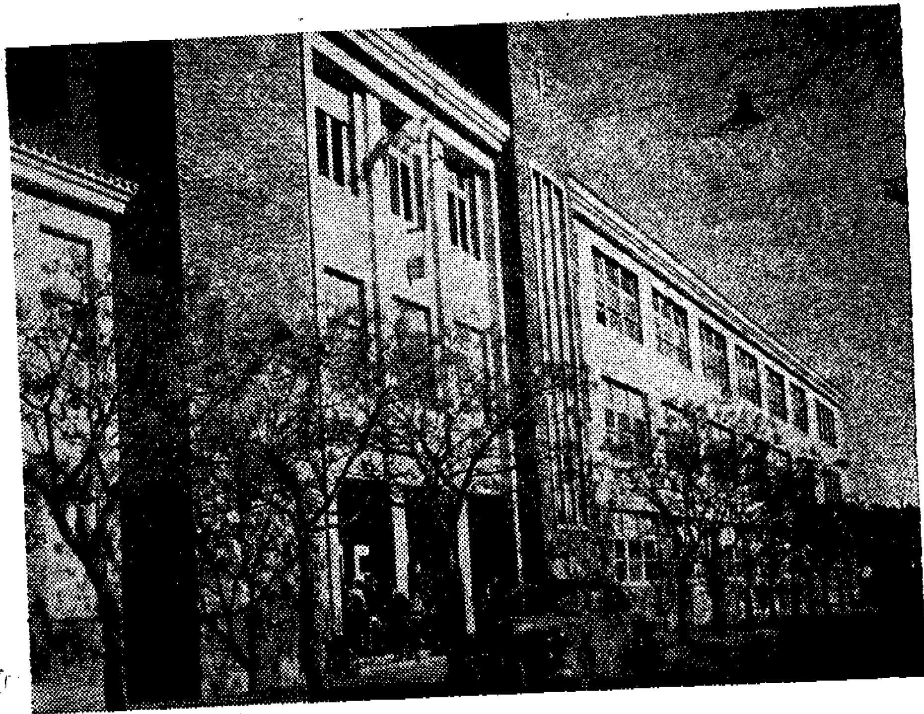
Frente del moderno edificio donde funciona la Escuela de Comercio, anexa a la Universidad Nacional del Sur.
