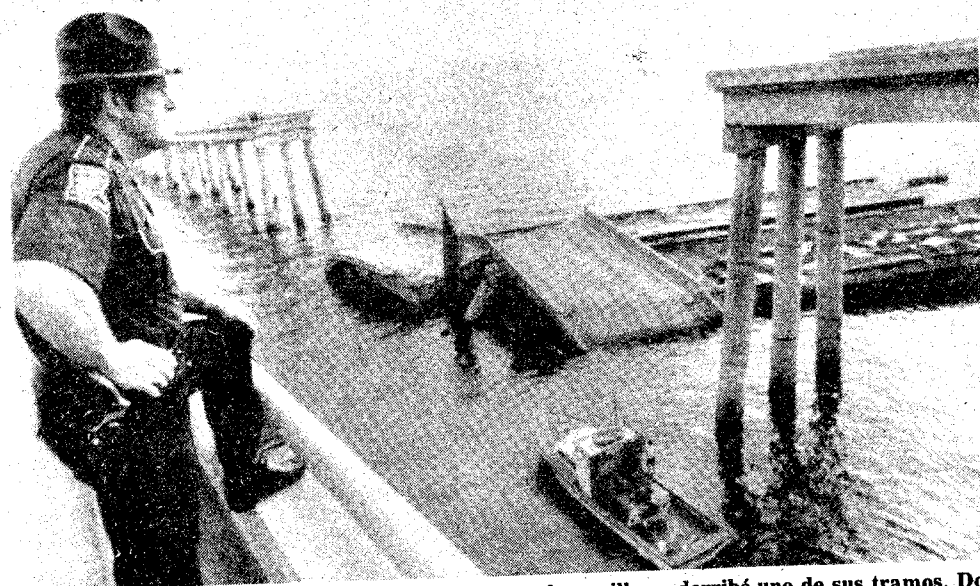
Un accidente poco común ocurrió en el lago Pontchartrain Causeway, (EE.UU.), cuando la barcaza de transporte Thrushday, embistió varias columnas del puente de 24 millas que une
