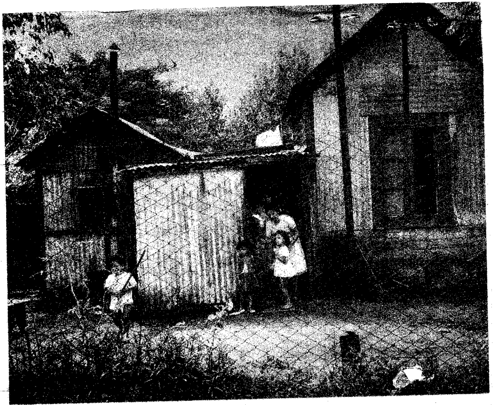
Las que se hicieron luego son así: de madera y chapas de fibrocemento.
