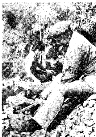
Preparando escombros para cimientos.
